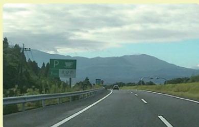
加久藤トンネルを抜けて 霧島連山の絶景を望む
