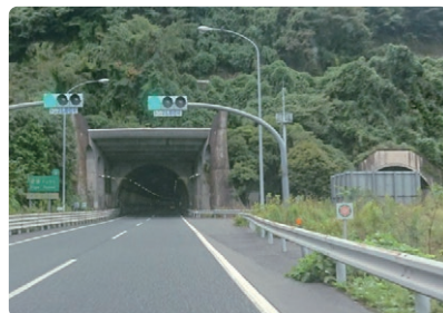
九州道最大の鬼門である肥後トンネルの入口
