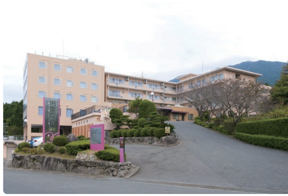
入り口から見た粕屋南病院の外観
