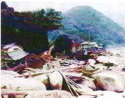
当時の被害状況
