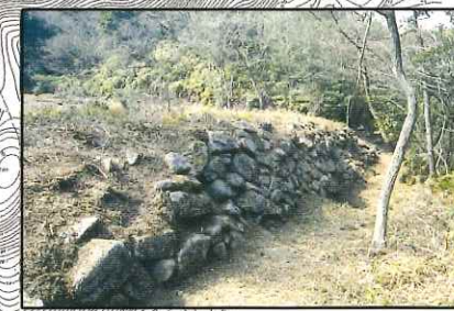
馬立場石塁 貯水池の堤と推定される遺構
