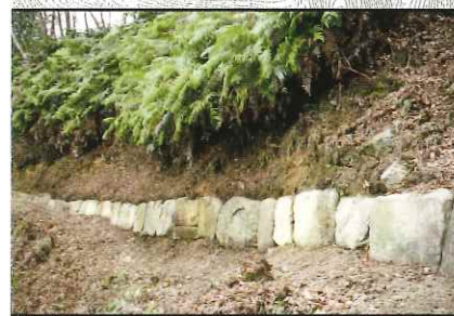
列石 土塁の基礎補強に並べられた石
